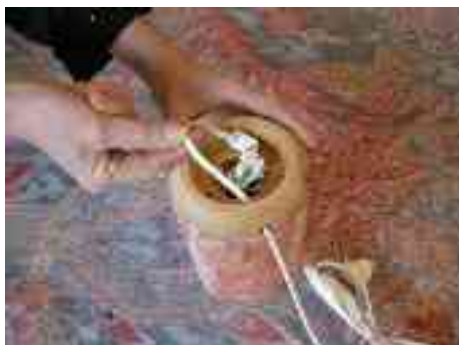
2 – Tirez doucement sur le fil d'alimentation électrique afin de le dégager
